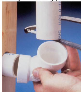
Bucha de redução com vazamento ou danificada
