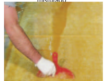
Espalhando a resina na manta de fibra de vidro
